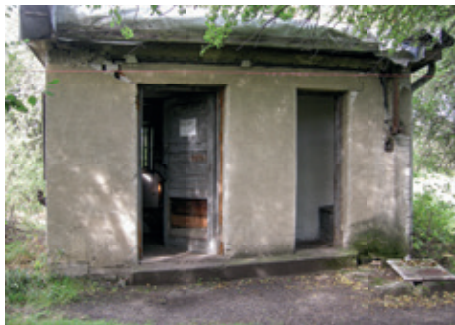
Obr. 16: Východní strana váhovny s hlavním vchodem (všimněte si posunutí stěny!) a vchodem na WC. Foto J. Chytil, 7. 10. 2020.
