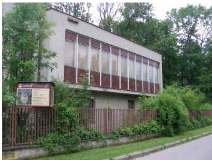
Původní podoba budovy Ornitologické stanice (přestavba 1979-1981)
