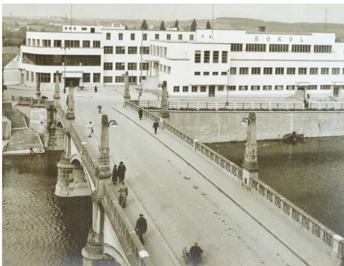
Stavbu přerovské sokolovny začali realizovat na jaře roku 1935 stavitelé Antonín Bartošek společně s Františkem Václavem Volfem. Dokončena byla o rok později a 11. 9.1936 slavnostně předána přerovským Sokolům.
