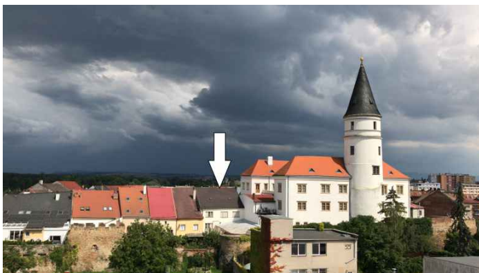
Celkový pohled na přerovský zámek a dvorní průčelí domů na západní straně Horního náměstí na snímku Petra Ludíka. Bílou šipkou vyznačena poloha domu č. 35, kde probíhají stavební úpravy.
