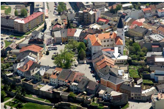
Zástavba historického centra Přerova s areálem přerovského zámku na Horním náměstí na leteckém snímku Jana Čepa. Bílou šipkou vyznačena poloha depositáře knihovny ve dvorním traktu domu č. 35.
