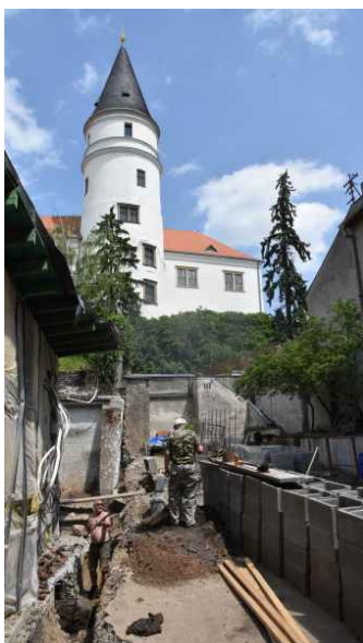
Archeologický tým během čištění stěn a dna výkopu pro založení opravované ohradní zdi. V pozadí věž přerovského zámku.
