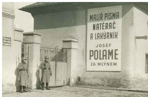
Německá stráž před vstupem do areálu obecního hospodářství v ulici Za Mlýnem, v sousedství obecné školy.
