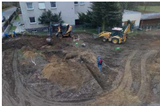
Úplně první rýha budoucích základů nové budovy. Konec listopadu 2020.
