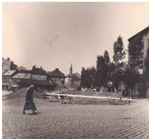
Rok 1944 žádné velké stavební výročí nezanechal, protože v době války byl stavební ruch pozastaven. Výjimkou však onoho roku byly požární nádrže a protiletadlové kryty, jež vznikly např. na Žerotínově náměstí.
