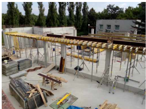
Obrysy nové budovy se začínají rýsovat. Srpen 2021.
