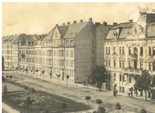
Rovných sto let letos oslaví dům pro státní zaměstnance na náměstí Svobody, jehož hrubou stavbu provedl stavitel Valenta z Brna a dokončení pak přerovské firmy.
