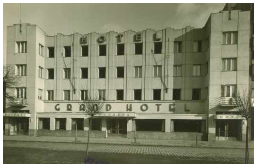
V prosinci 1934 byl s velkou slávou otevřen v Husově třídě nejmodernější přerovský hotel – Grandhotel Lipner – dílo architekta Leopolda a stavitele Kovaříka.
