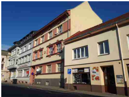
Současná podoba objektu poštovního úřadu v Bratřské ulici č. p. 114, který stojí na místě hostince U Jonášů, při jehož bourání byl v roce 1923 nalezen „přerovský poklad“.
