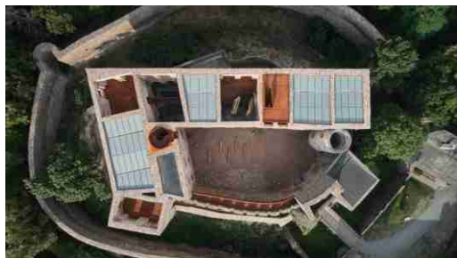
Pohled z ptáčích perspektiv na opravený palác hradu Helfštýna se skleněným zastřešením.
