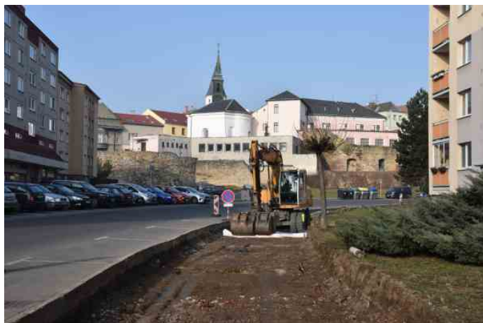
Celkový pohled na niveletu skrývky v místě budované cyklostezky v Kozlovské ulici. Pohled od východu směrem k Hornímu náměstí.
