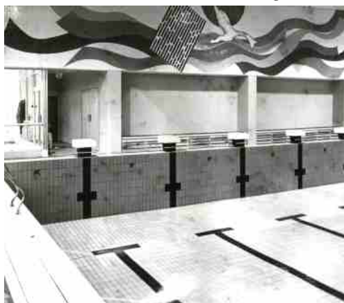
První napouštění bazénu v den zahájení provozu 17. 11. 1978
