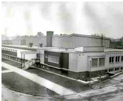
Celkový pohled na budovu krytého bazénu
