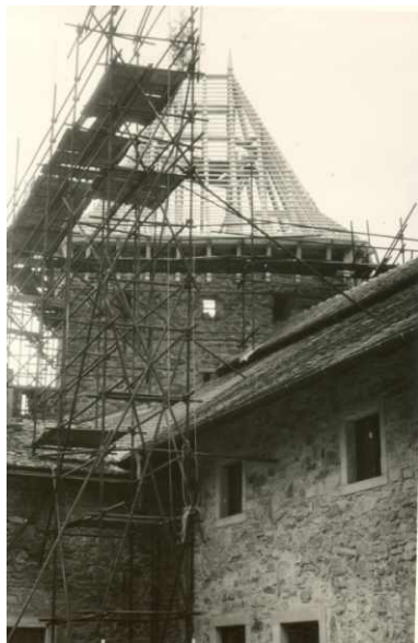
Pohled na právě probíhající zastřešování nárožní podkovovité bašty z druhého nádvoří. Rok 1992.
