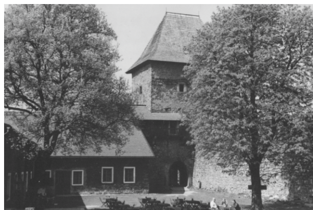
Pohled na předsunutou hranolovou věž po roce 1966, již se změněným sklonem střechy strážnice, zastřešenou pavlačí i věží samotnou. Bývalá strážnice má však původní rytmus oken a dvoukřídlých dveří později zcela pozměněný.
