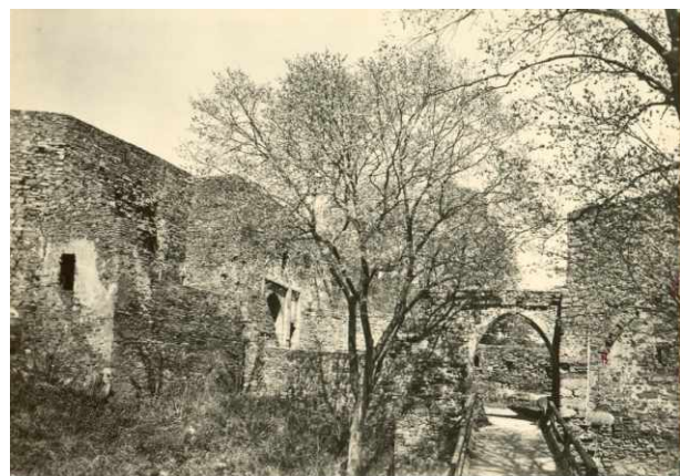
Pohled na třetí most zachycující i okolní stavby; vpravo Kostkova věž, vlevo v popředí barokní přístavek a za ním čtvrtá brána. Ve 30. letech značně degradovaným stavbám chybělo množství pojava, zdívo drželo v podstatě nasucho.
