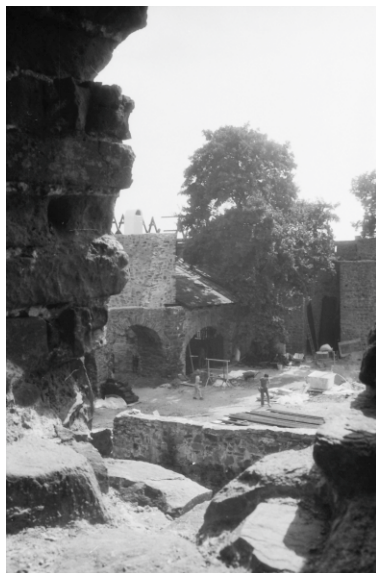
Pohled na třetí nádvoří s výstavbou budovy kovárny v roce 1988. Tesaři zrovna dokončují vrcholovou část krovu sedlové střechy. Bílou vápennou maltou září dozděné části klenebního oblouku i opěrné zdi čtvrté brány. Foto Petr Plašil, 1988.
