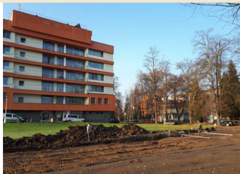
Plošná skrývka v místě výstavby parkovacích stání před budovou
