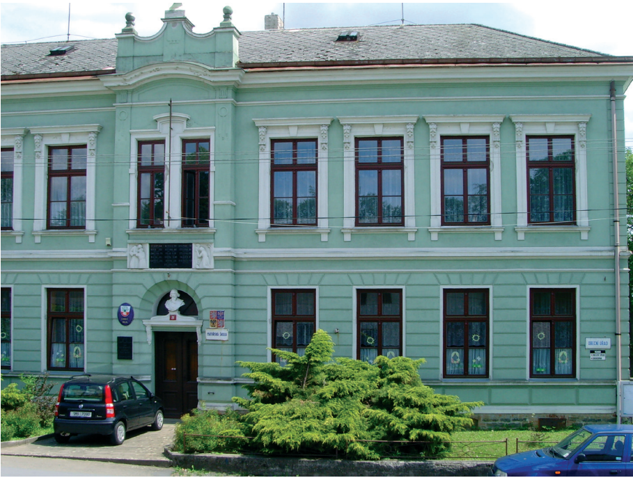
Budova bývalé školy v Buku
