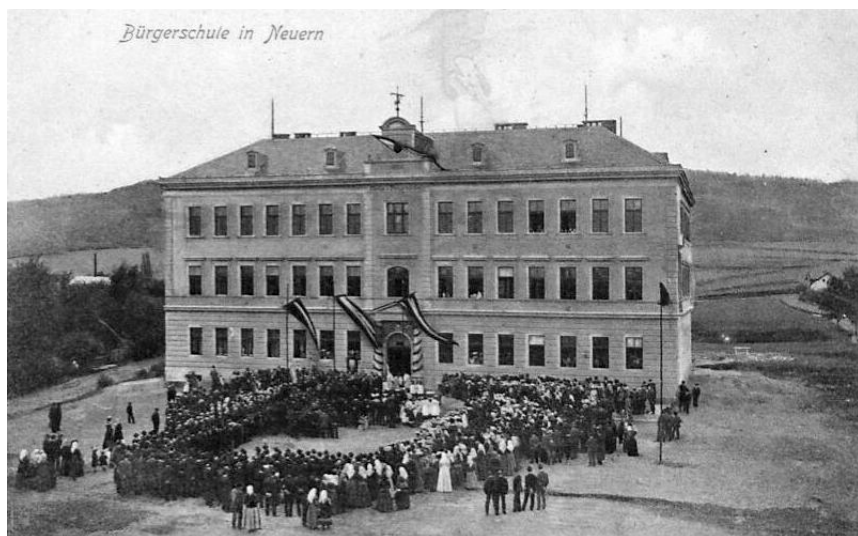
Fotografie budovy měšťanské a obecné školy Nýrsko z roku 1904, SOkA Klatovy
