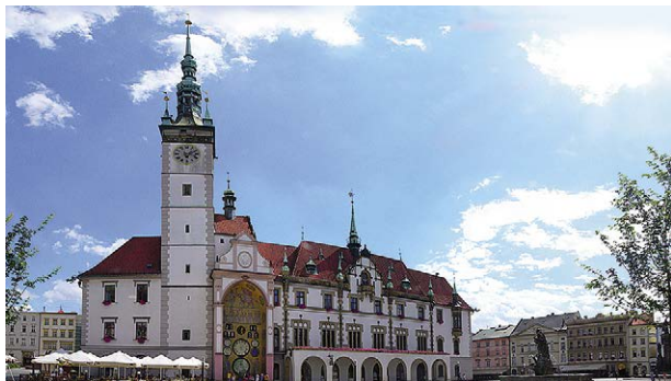
Pohled na budovu olomoucké radnice od severu s orlojovým výklenkem vedle radniční věže
