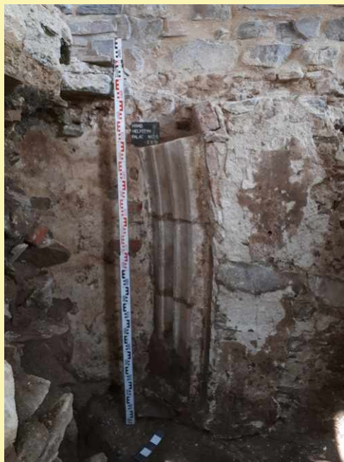
Profilované ostění gotického pískovcového portálu odkrytého pod současnou podlahou renesančního paláce
