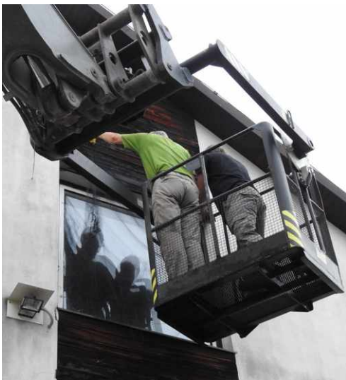
Instalace sítě před ostění domu v Ludslavicích za pomoci vysokozdvížečného ramene nakladače slámy.
