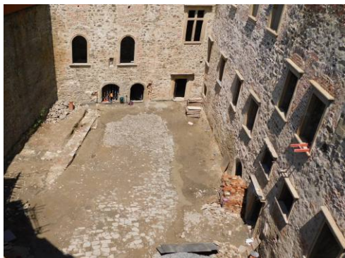
Celkový pohled na odkrytou část renesanční dlažby a základy hospodářské přístavby na nádvoří paláce
