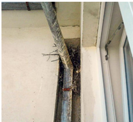
Obr. 6 / Fig. 6: Detail umístění hnízda sojky obecné na okapové rýně. / Detail view on a location of European jay nest on a gutter. Foto 22. 4. 2014, J. Sychra.
