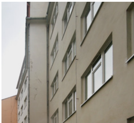
Obr. 5 / Fig. 5: Celkový pohled na umístění hnízda sojky obecné na okapové rýně. / Total view on a location of European jay nest on a gutter. Foto 22. 4. 2014, J. Sychra.
