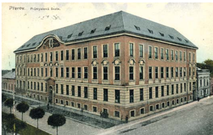
Budova průmyslové školy po dostavbě
