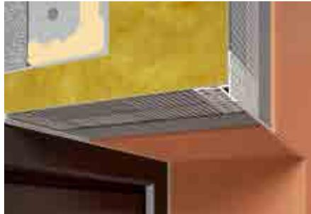
**LTDU Tropfkante mit einer nicht zuerkannter Unterputz-Tropfkante** und Glasfaser-Armierungsgewebe zum Putzabschluss und zur Sicherstellung der Wasserableitung an den oberen Öffnungslaibungen im WDVS
