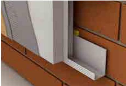
**PVC Anfangsleiste** zum Auflegen der Dämmstoffplatten in der Dämmebene im WDVS
