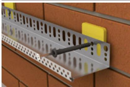
**ZHH / ZHH-N** tasselli a martello con testa bombata e vite metallica per l'ancoraggio dei profili di partenza nell'isolamento termico
