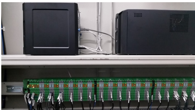
HTTP server a hlavní controller (PLC)
