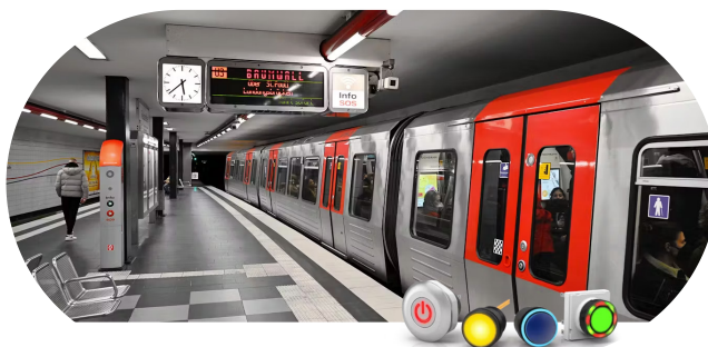
Infrastruktura pro plynulý železniční provoz s intuitivním ovládním.
