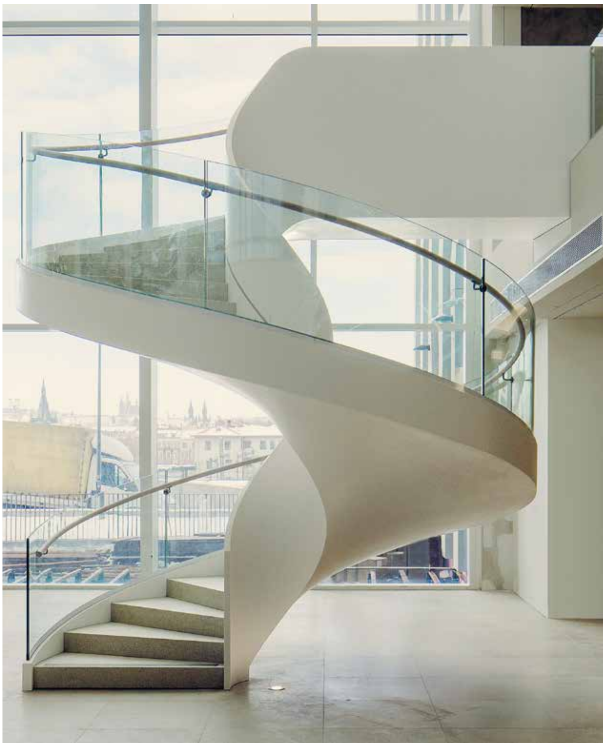
Fertige Treppe mit Corian®-Material ausgekleidet / Finished stairs covered with Corian® material
